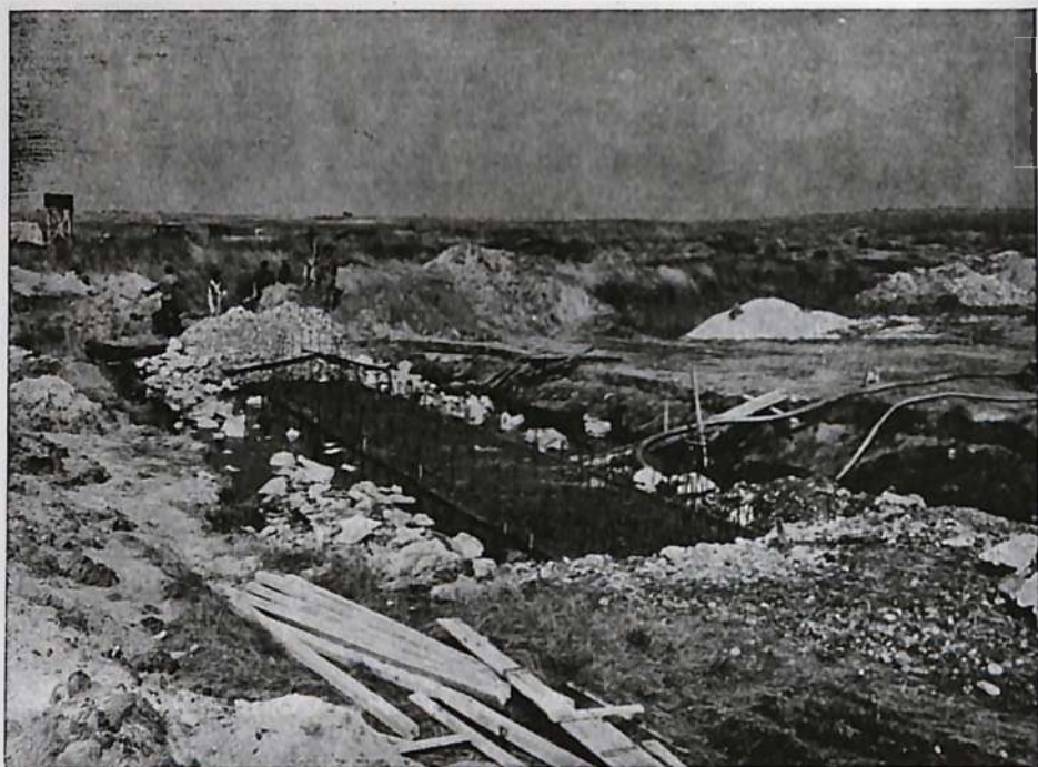
α. Κατασκευή νέων συλληπτικών εγκαταστάσεων λιμνοθάλασας «Άλυκη» Μέσης.
